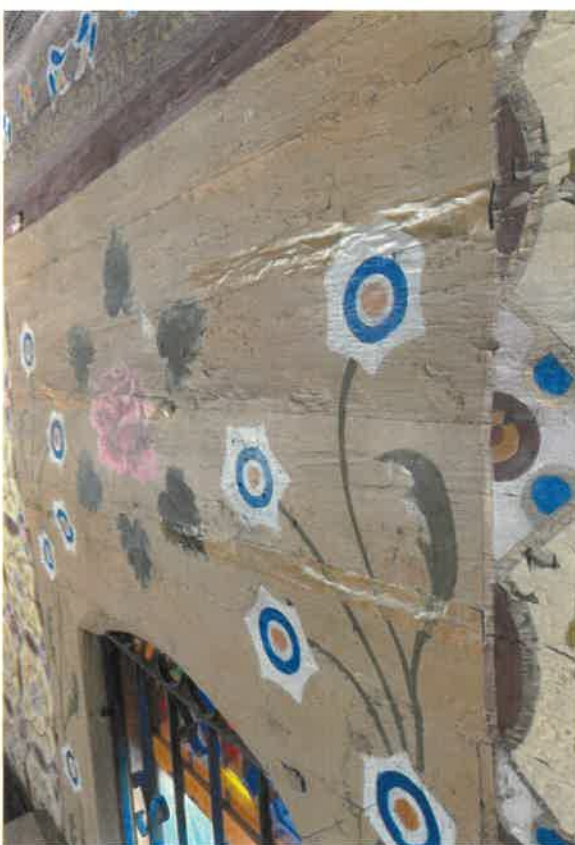
Fot.41. Kościół parafialny pw. św. Jakuba Apostoła i Katarzyny Aleksandryjskiej w Raciechowicach. Widoczny fragment dekoracji malarskiej północnej ścian nawy. Eksponowana polichromia jest wynikiem przemalowania „po formie”, wykonanym najpewniej w latach 80 tych XX w. Pierwotną dekorację malarską wykonano w latach 30 XX w. przez S. Wymiatałkę z Wieliczki. Zauważalne liczne spękania występujące w obrębie polichromii. Ponadto w celu zakamuflowania pęknięć powstałych w miejscach łączeń desek wprowadzono dwustronną taśmę klejącą. Fot. Joanna Babraj- Mędrała 2024.
