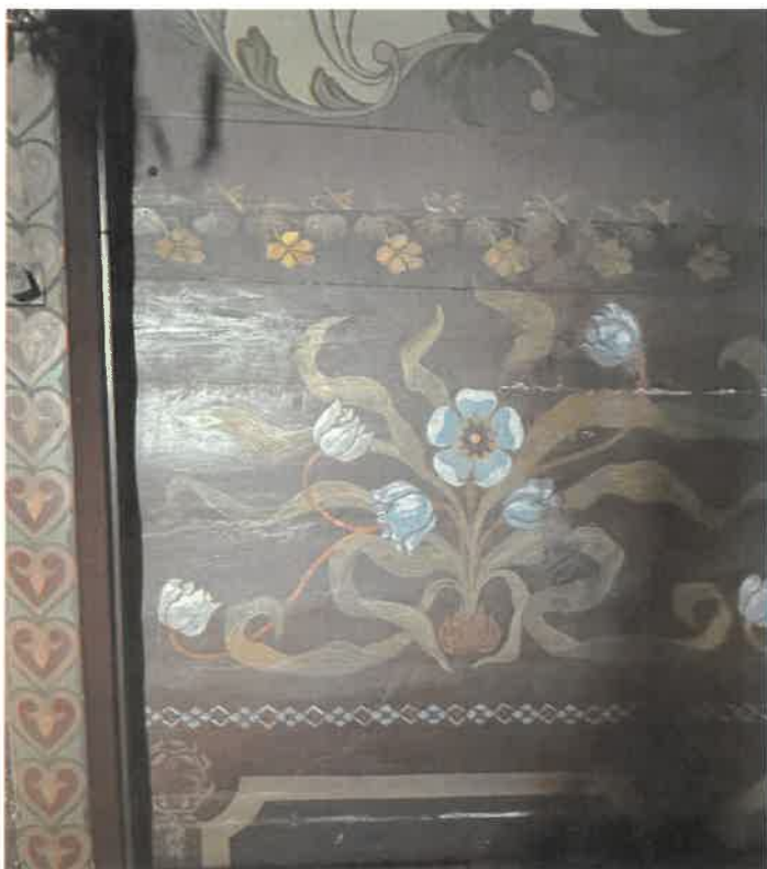
Fot.20. Kościół parafialny pw. św. Jakuba Apostoła i Katarzyny Aleksandryjskiej w Raciechowicach. Widoczny fragment dekoracji malarskiej zdobiący północną ścianę prezbiterium. Eksponowana polichromia wykonana w latach 30 XX w. przez S. Wymiatałką z Wieliczki. Stan przed konserwacją. Fot. Joanna Babraj-Mędrala 2024.
