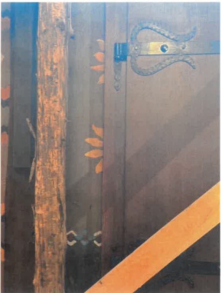
Fot.49. Kościół parafialny pw. św. Jakuba Apostoła i Katarzyny Aleksandryjskiej w Raciechowicach. Widoczny fragment drzwi na południowej ścianie świątyni. Zauważamy wtórny otwór wejściowy wykonany za czasów probostwa Ks. Jana Osadzińskiego ( 1953- 1993 r.). Otwór obecnie zaślepiony i zakryty skrzydłem drzwi dębowych (wykonanych współcześnie). Stan przed konserwacją. Fot. Joanna Babraj- Mędrala 2024.
