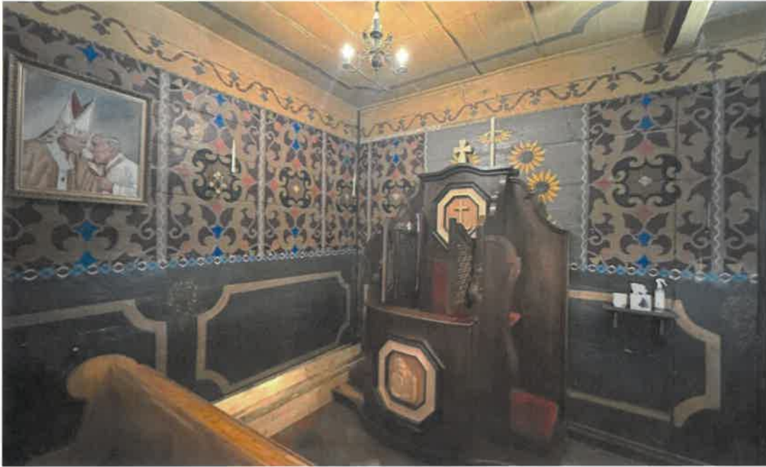
Fot.22. Kościół parafialny pw. św. Jakuba Apostoła i Katarzyny Aleksandryjskiej w Raciechowicach. Widoczne ściany w części zachodniej świątyni pod chórem. Eksponowana polichromia jest wynikiem przemalowana „po formie”, wykonanym najpewniej w latach 80 tych XX w. Pierwotną dekorację malarską wykonano w latach 30 XX w. przez S. Wymiatałką z Wieliczki. Stan przed konserwacją. Fot. Joanna Babraj- Mędrała 2024.
