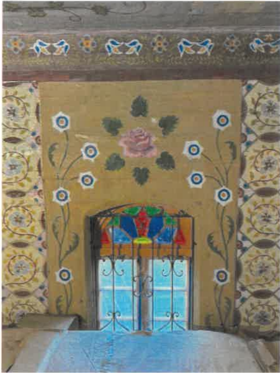
Fot.28. Kościół parafialny pw. św. Jakuba Apostoła i Katarzyny Aleksandryjskiej w Raciechowicach. Widoczny fragment północnej ściany nawy wraz z otworem okiennym (pierwszy licząc w kolejności od chóru). Ekspozowana polichromia jest wynikiem przemalowania „po formie”, wykonanym najpewniej w latach 80 tych XX w. Pierwotną dekorację malarską wykonano w latach 30 XX w. przez S. Wymiatałkę z Wieliczki. Stan przed konserwacją. Fot. Joanna Babraj- Mędrała 2024.
