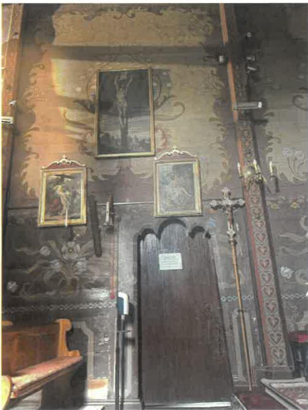
Fot.19. Kościół parafialny pw. św. Jakuba Apostoła i Katarzyny Aleksandryjskiej w Raciechowicach. Widoczna ściana północna. Eksponowana polichromia wykonana w latach 30 XX w. przez S. Wymiatałką z Wieliczki. Stan przed konserwacją. Fot. Joanna Babraj- Mędrala 2024.
