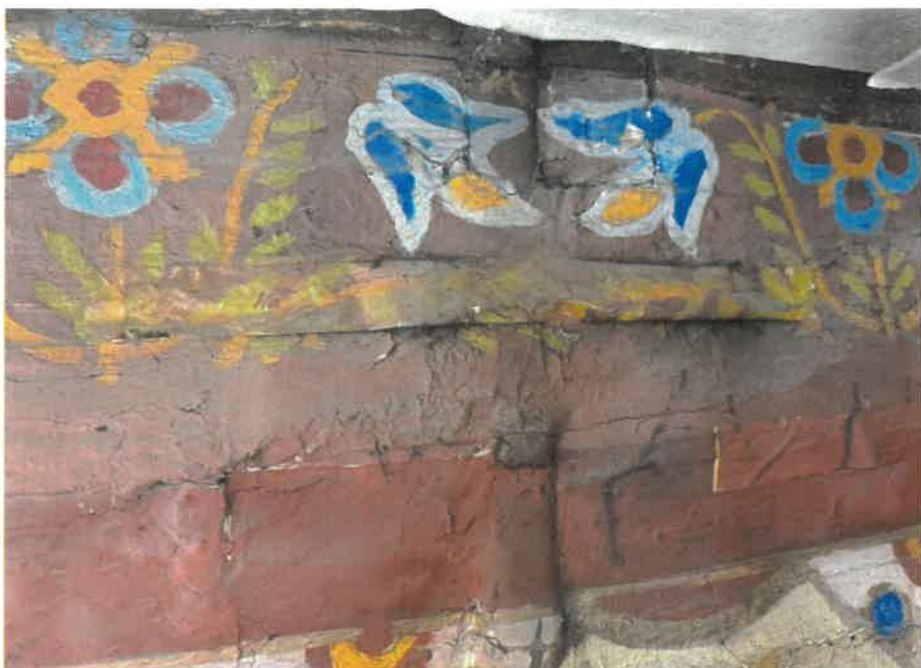
Fot.40. Kościół parafialny pw. św. Jakuba Apostoła i Katarzyny Aleksandryjskiej w Raciechowicach. Widoczny fragment dekoracji malarskiej północnej ścian nawy. Widoczna polichromia została wykonana w 1930 r. a następnie około 1980 r. „odświeżona” wykorzystując poprzednią formę dekoracji i kompozycję. Zauważalne liczne spękania występujące w obrębie polichromii. Ponadto w celu zakamuflowania pęknięć powstałych w miejscach łączeń desek wprowadzono dwustronną taśmę klejącą. Fot. Joanna Babraj- Mędrała 2024.
