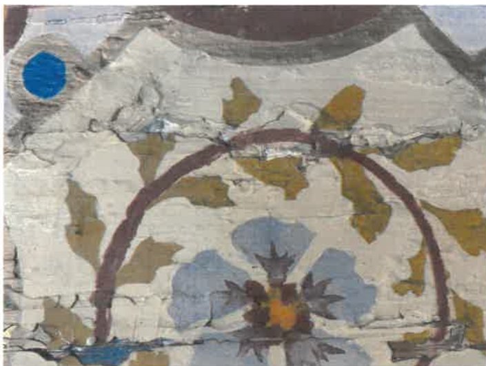
Fot.9. Kościół parafialny pw. św. Jakuba Apostoła i Katarzyny Aleksandryjskiej w Raciechowicach. Widoczny fragment dekoracji malarskiej północnej ściany nawy. Widoczna polichromia została wykonana w 1930 r. a następnie około 1980 r. „odświeżona” (poprzez przemalowanie) wykorzystując poprzednią formę dekoracji i kompozycję. Zauważalne liczne spękania występujące w obrębie polichromii, ubytki i odspojenia. Fot. Joanna Babraj- Mędrala 2024.
