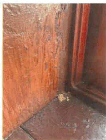
A. Zdjęcie wykonane o 9 rano. Widoczna mała ilość pyłu drzewnego poniżej miejsca żerowania.
