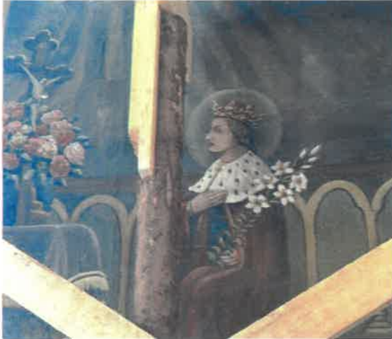
Fot.3. Kościół parafialny pw. św. Jakuba Apostoła i Katarzyny Aleksandryjskiej w Raciechowicach. Widoczny fragment figuralnej dekoracji ściany południowej. Widoczny św. Kazimierz. Polichromia wykonana w latach 30 XX w. przez S. Wymiątałkę aktualnie przemalowana zapewne w latach 80 XX w. Jako podobrazie dla polichromii wykorzystane zostało deskowanie ścian. Fot. Joanna Babraj- Mędrala 2024.
