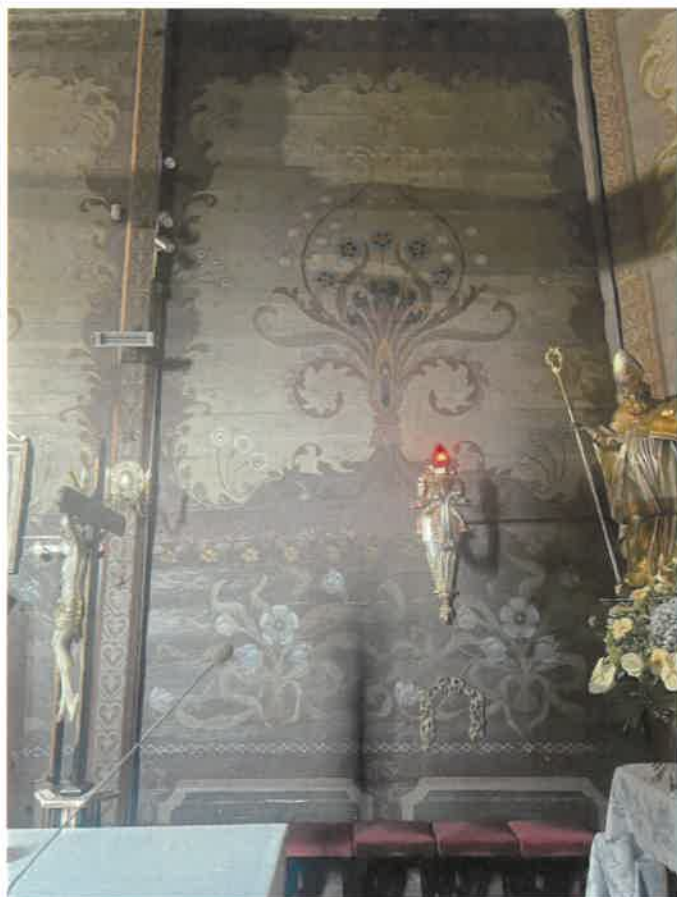
Fot.21. Kościół parafialny pw. św. Jakuba Apostoła i Katarzyny Aleksandryjskiej w Raciechowicach. Widoczna, ściana północna. Eksponowana polichromia wykonana w latach 30 XX w. przez S. Wymiatałką z Wieliczki. Stan przed konserwacją. Fot. Joanna Babraj-Mędrala 2024.
