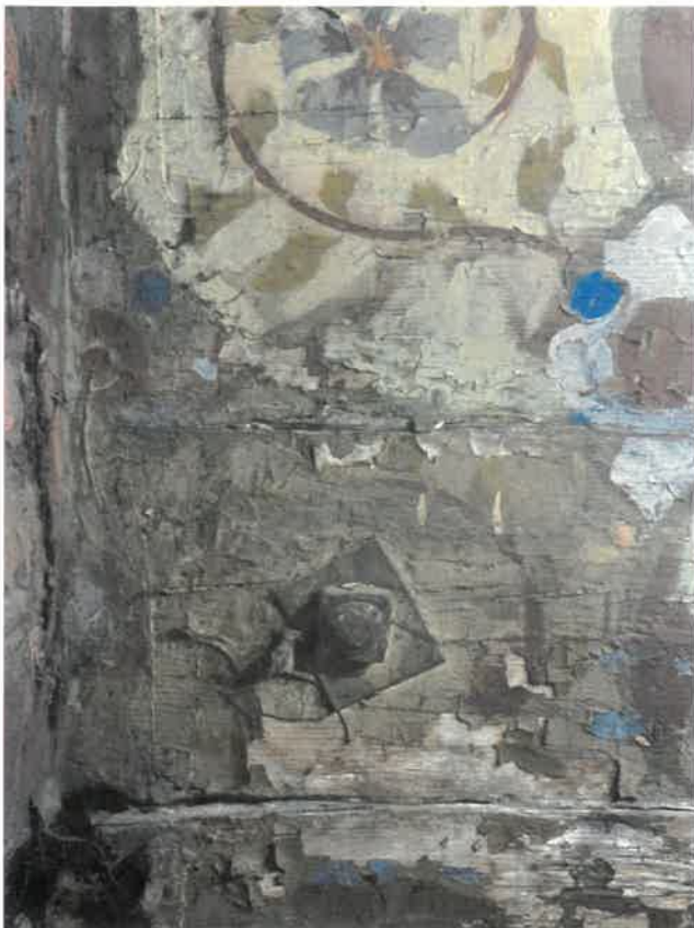
Fot.38. Kościół parafialny pw. św. Jakuba Apostoła i Katarzyny Aleksandryjskiej w Raciechowicach. Widoczny fragment dekoracji malarskiej w narożniku północno- wschodnim nawy tuż za ołtarzem. Na przedstawionej polichromii wyraźne rozgraniczenie między partią przemalowaną w latach 80 XX w. a tą wykonaną w roku 1930. Całość malatury mocno zabrudzona, spękana i łuszcząca się. Stan przed konserwacją. Fot. Joanna Babraj- Mędrała 2024.
